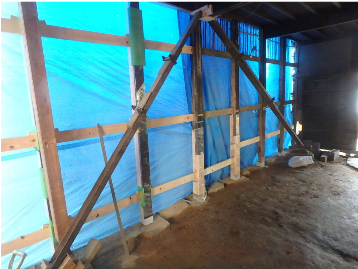
腐食部分取替
